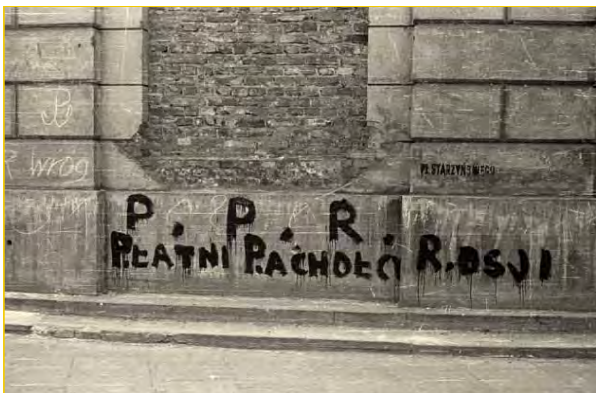
Fotografia z okresu okupacji niemieckiej. Napis na ścianie budynku Banku Polskiego przy ul. Rymarskiej 1 (pl. Bankowy). Warszawa, lipiec 1944 r.
