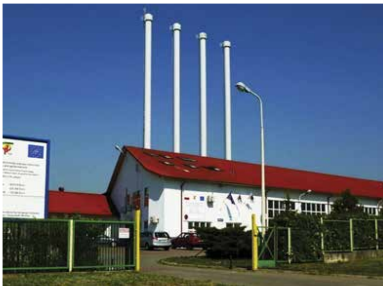
Zdj. 2. Ciepłownia geotermalna w Pyrzycach o mocy 40 MW.
