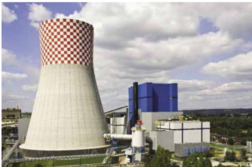
Zdj. 1. Blok Elektrowni Łagisza o mocy 460 MW posiadający kocioł fluidalny CFB.
