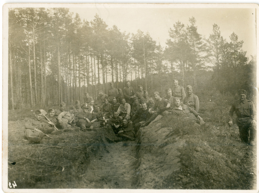
Zdj. 1. Junacy i żołnierze KOP podczas prac ziemnych przy fortyfikacjach. Pułk KOP „Sarny”.
