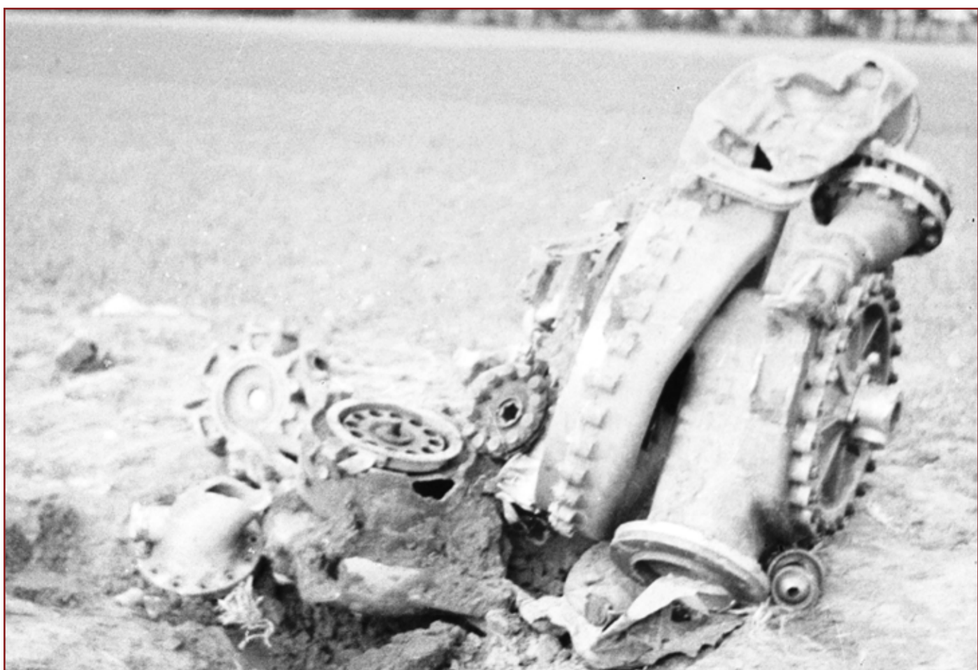
Wykonane przez wywiadowców AK fotografie sprężarki pocisku raketowego V-2.
