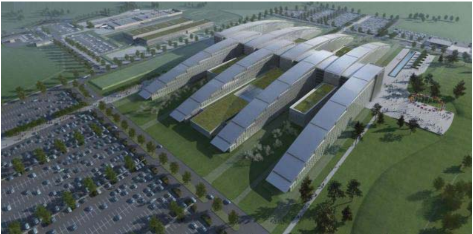
Zdj. 11. Nowa centrala NATO w Brukseli, widok z lotu ptaka, proj. Skidmore, Owings and Merrill, 2014. Źródło: Skidmore, Owings and Merrill.
